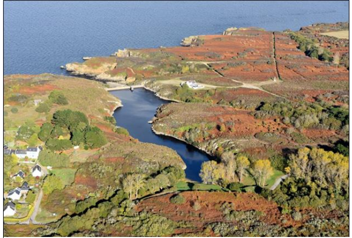
Figure 58 : Le barrage de Port Melin (Cliché : Géos/AEL)
