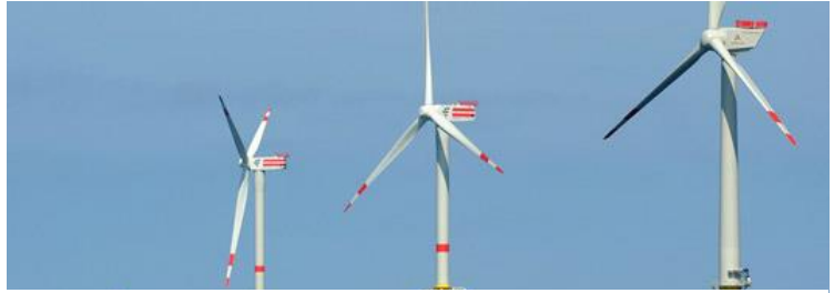
Figure 79 : Parc éolien offshore "Alpha Ventus", à 45 km de l'île de Borkum, Allemagne (@photo)
