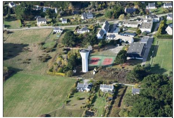
Figure 59 : Château d'eau de Créhal (Cliché : Géos/AEL)
